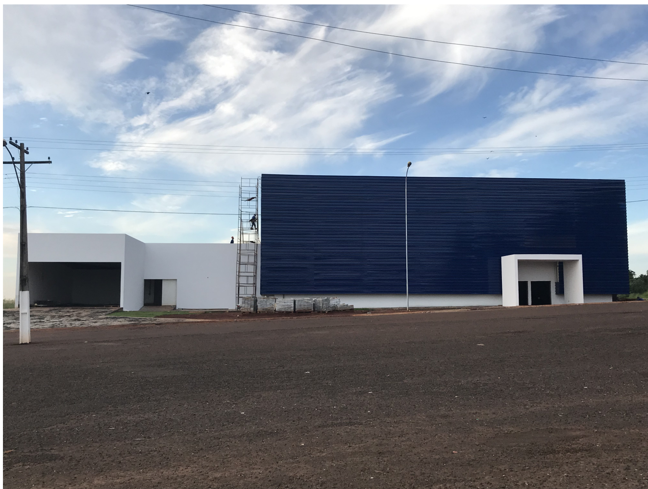
FIGURA 01 – FACHADA CENTRO DE CONVENÇÕES
